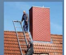
Schritt 2: Zuerst wird der Edelstahlrahmen über dem alten Schornstein gestülpt und fest mit dem Mauerwerk verankert.
