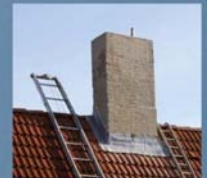
Schritt 1: Der vormontierte Stülpkopf wird vom Installateur zerlegt und in Einzelteilen problemlos aufs Dach transportiert.
