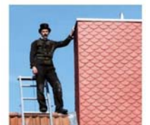
Schritt 4: Zum Schluss wird das Abschlusselement aufgesetzt und verschraubt – fertig ist Ihr neuer Schornstein in echter eka-Qualität!
