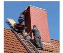
Schritt 3: Jetzt werden die vier witterungsbeständigen Verkleidungselemente in die Rahmenkonstruktion eingehängt.
